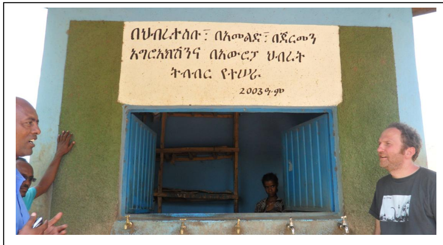
A water kiosk
